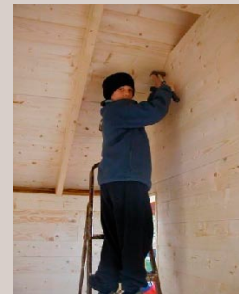
Innvendig panel blir montert, og det blir lakkert for lettere rengjøring.
