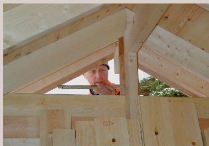
Åpning i begge møner for lufting. Blir dekket med hønsenetting.
