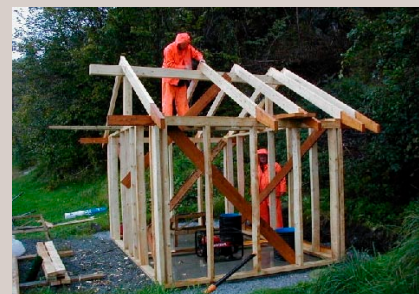
Betongplaten er støpt, og sperrene blir montert.
