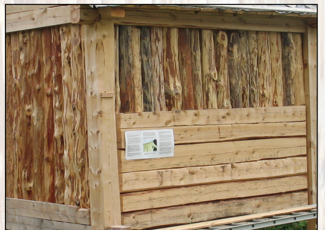
Skjeltrener (de som står på høykant) og sleppstokkene (de som ligger) kan tas ut og inn etter behov
