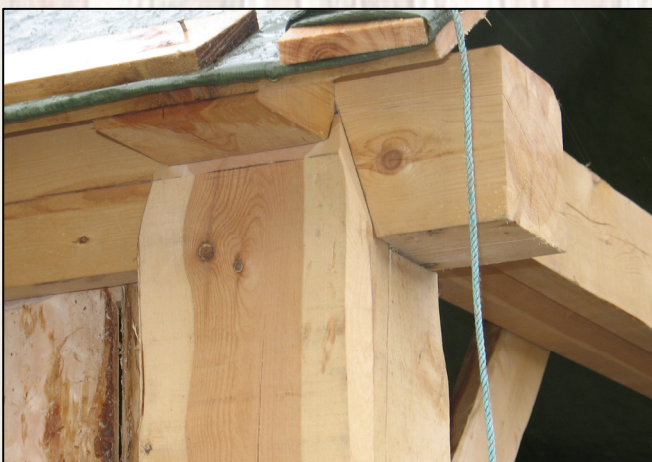
Felling mellom stav og raftstokk og stav og syll. Fellingene følger det tradisjonelle, men er tilpasset et mal-system som rasjonaliserer produksjonen vesentlig.
