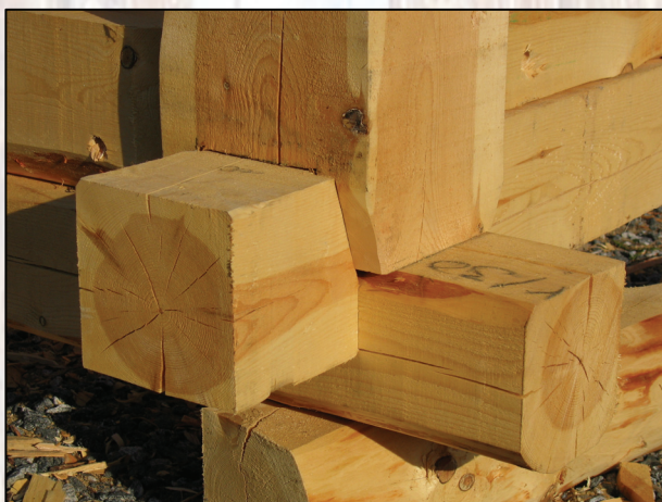
Felling mellom stav og raftstokk og stav og syll. Fellingene følger det tradisjonelle, men er tilpasset et mal-system som rasjonaliserer produksjonen vesentlig.
