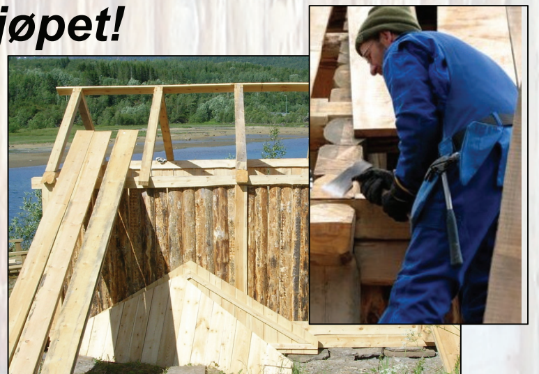
Skjeltrener (de som står på høykant) og sleppstokkene (de som ligger) kan tas ut og inn etter behov
