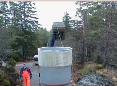
Byggegroppen er ferdig med grøft for drenering.
