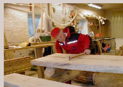
Sittebenkene og bordplatene blir montert.
