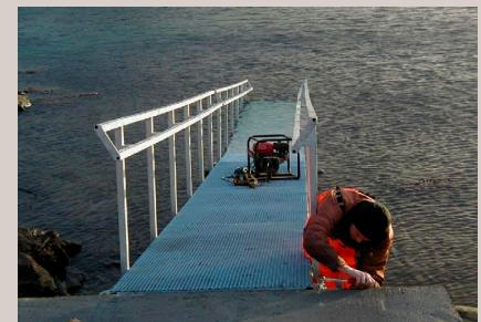
Rampen blir skrudd fast til fundamentet.
